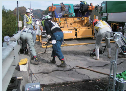
(床版打設状況)
