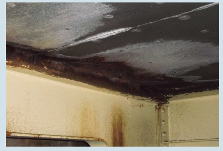
(橋の下面腐食・劣化)【山添橋】
