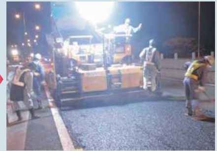
(舗装復旧状況)
